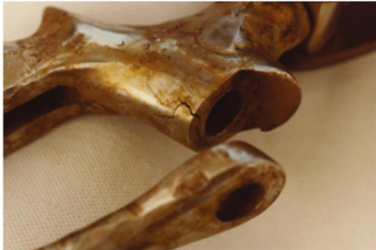
Gambar 3.7: Korosi tegang pada pipa (Pedefferri and Lazzari, 2018)
