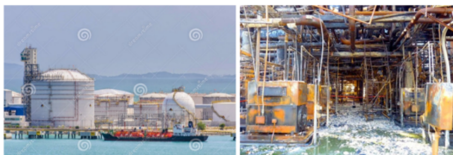
Gambar 4.2: Pabrik Kimia yang terkorosi akibat lingkungan agresif pantai (Cakbentra, 2015)
